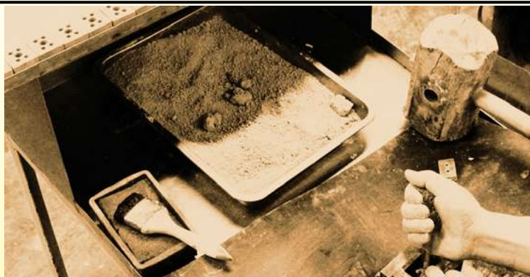
Клемнные колодки из фарфора, сделанные вручную путем прессования молотком: заполнение влажным гранулятом вручную (частная коллекция). Сушка электротехнического фарфора после прессования (частная коллекция).
